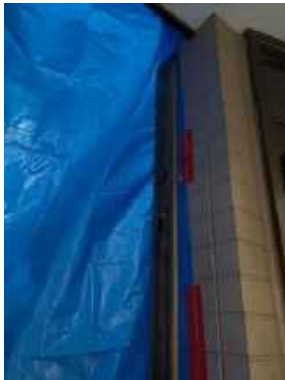
③外壁とシートを角材で固定。シートの反対側は足場のシート等と繋ぐ。
