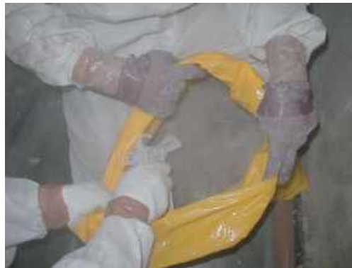
図 4.7.76 袋詰めした石綿廃棄物への粉じん飛散防止処理剤を散布
