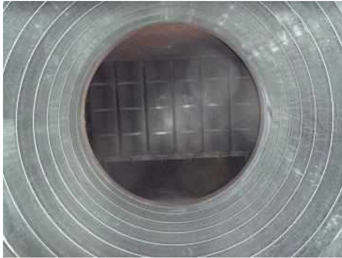
写真Ⅲ－5 吸込ダクト内部（φ1,300）の例
