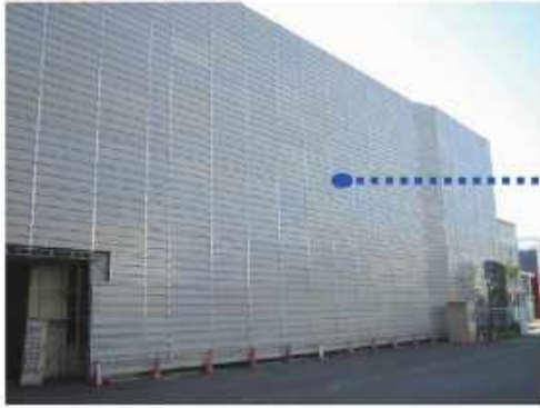
図 4.7.17 建屋周囲に設置した、通常の解体工事で使用する防音パネル（枠組足場に取付け、内部の石綿除去工事を視覚的にも遮断）
