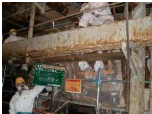
図 4.10.8 グローブバッグ取付作業中
