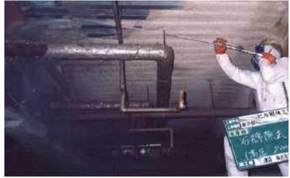
図 4.7.59 ウォータージェット工法の例
