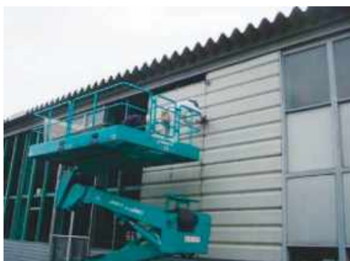
壁金物取外し
