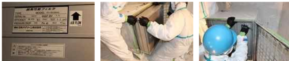
図 4.7.86 フィルタの取り付け
