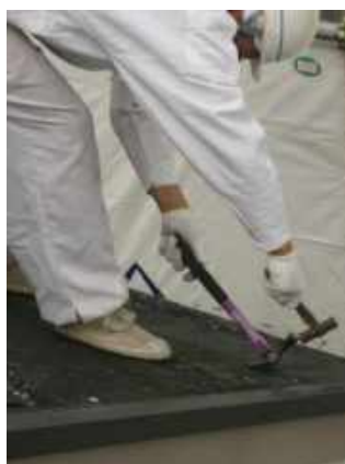
固定部分の取外し※
