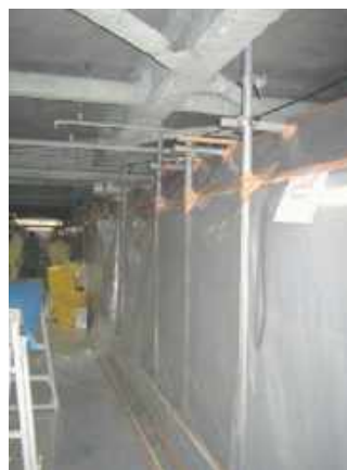
図 4.7.6 同上施工区画 (内部側、右外側が車路)
