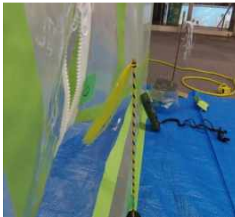
図 4.14.11 吹き流しによる確認
