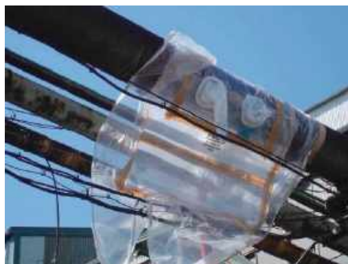
図 4.10.3 切断箇所へのグローブバッグ取付
