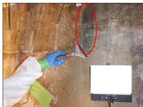
図4.15.8 コンクリート壁面に残った石綿の除去 (スクレーパカッター)
