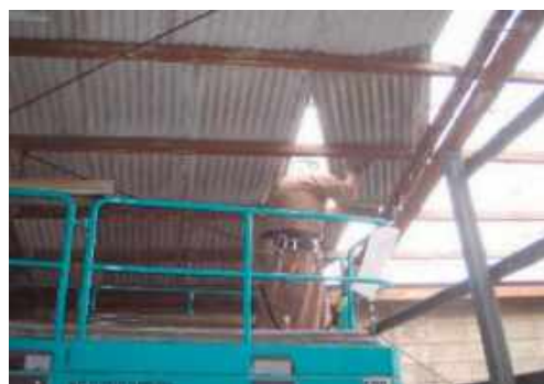
屋根スレート取外し
