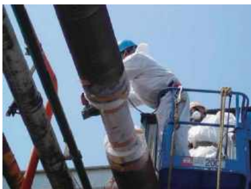
図 4.10.4 切断箇所の保温材除去と養生
