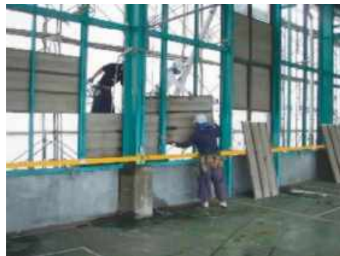
壁石綿含有成形板取外し
