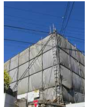
⑥外周は防火・防音シート等(通気性がない素材)で囲う。
