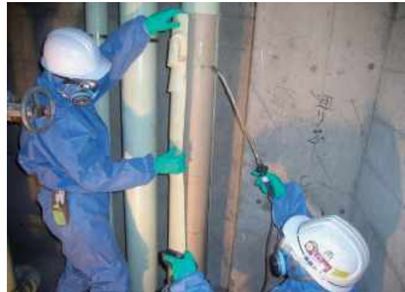
図 4.8.3 保温材の湿潤化→取り外し
