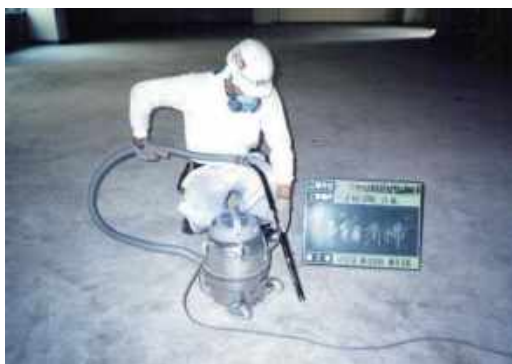
図4.11.21 清掃 高性能真空掃除機使用例
