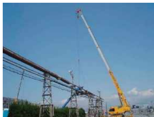
図 4.10.5 配管の吊り下ろし
