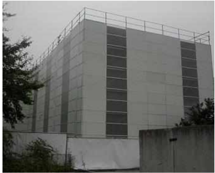
図 4.7.33 防音パネル／採光防音パネル施工例
