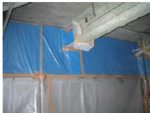
図 4.7.12 壁面の負圧隔離養生例 (作業場内側)
