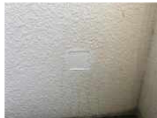
(固化および簡易補修後)
