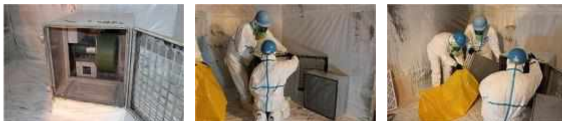
図 4.7.85 HEPAフィルタの交換
