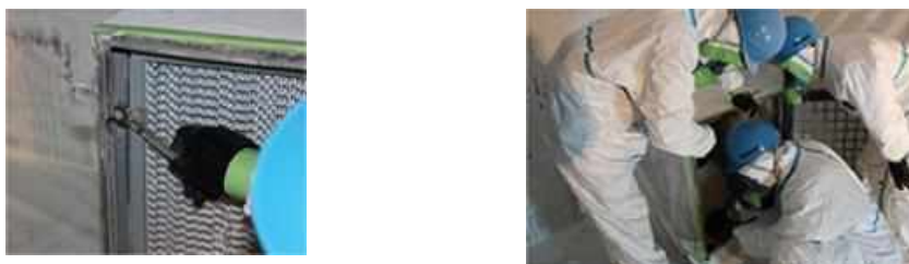
図 4.7.84 HEPAフィルタの留め付の緩み点検
