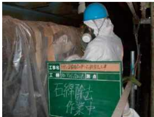
図 4.10.9 石綿除去作業中 1
