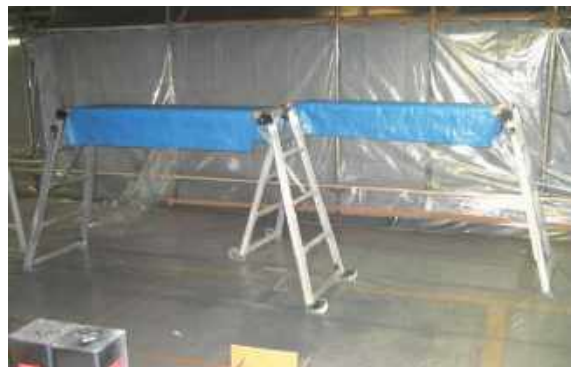
図 4.7.57 可搬式作業台の例
