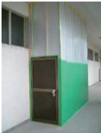
図 4.7.7 教室前廊下の施工区画 (外部側)
