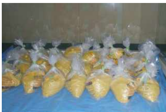
図 4.7.78 除去した石綿廃棄物の保管
