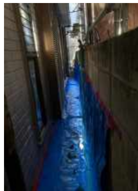
⑤床部シート養生の設置(通気性がない素材)※奥や手前の端も確実に囲う。
