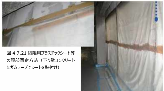
図 4.7.22 開口部の負圧隔離養生（防災シートの内側をプラスチックシート等で養生）
