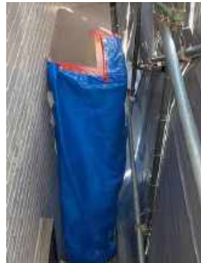
④下屋の端部での隔離養生の外観。
