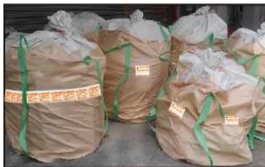
図4.11.22 石綿含有廃棄物の保管例
