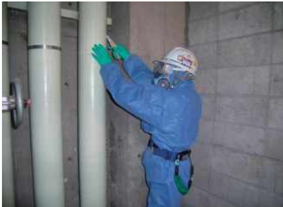
図 4.8.2 保温材被覆撤去
