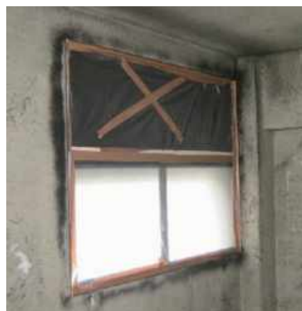
図 4.7.14 窓、換気口の負圧隔離養生例
