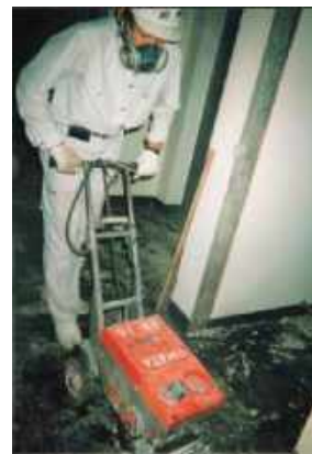
図4.11.12 石綿含有ビニル床タイルの 除去例
