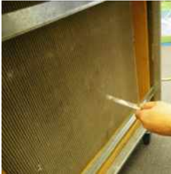
図 4.7.48 HEPA フィルタ面
