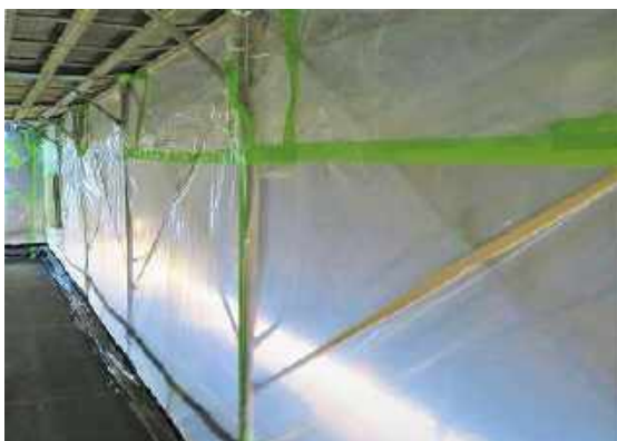
周囲への飛沫飛散防止養生例（内部）
