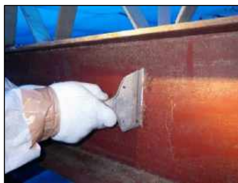
図4.15.5 再付着した石綿の除去
