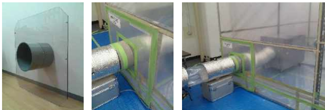
図4.14.14 排気ダクト貫通パネル例
