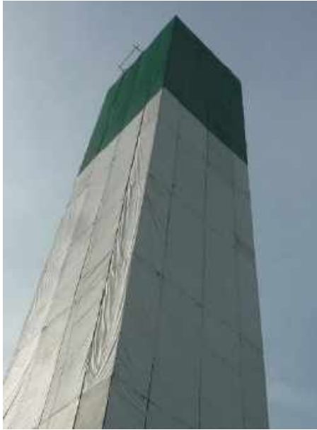
図 4.7.32 垂直ネットによる煙突頂部養生例
