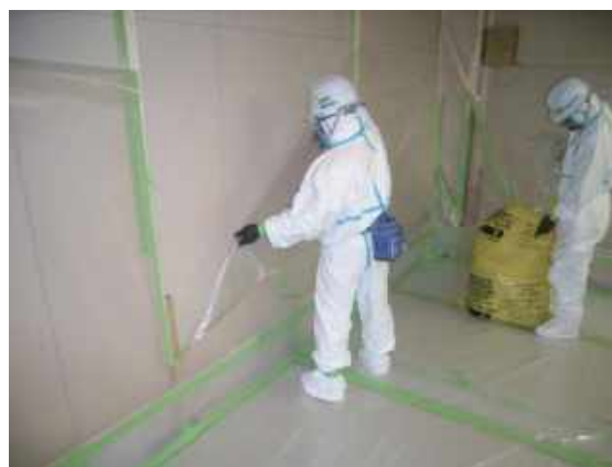
図 4.7.91 隔離シートの撤去
