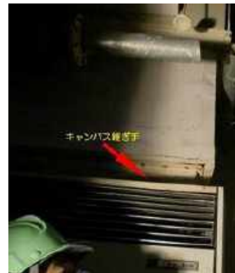
（参考資料）写真 6-11 キャンバス継ぎ手
