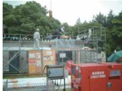
図 4.10.17 折板をはがしているところ
