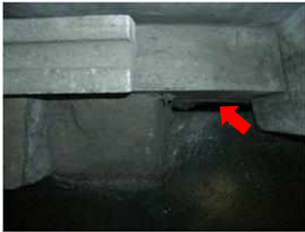
（参考資料）写真 6-8 スラブ層間塞ぎ 充填材なし
