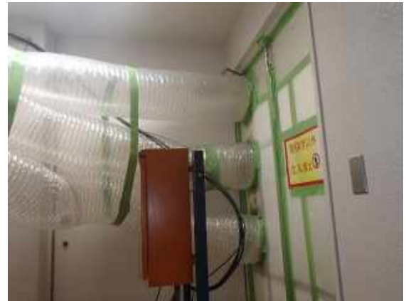
図 4.7.47 排気ダクトと隔離の取合い （隙間を完全に封鎖）
