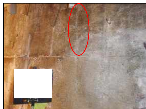
図4.15.10 取り残しの除去の確認
