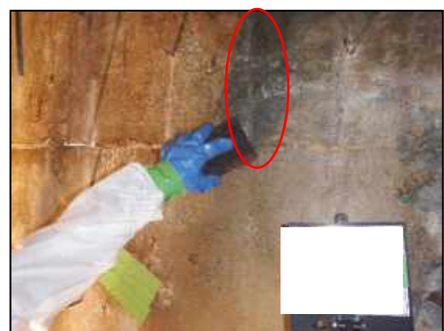
図4.15.9 コンクリート壁面に残った石綿の除去 (特殊たわし)
