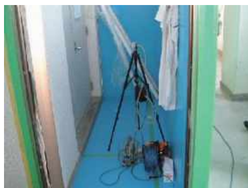
図 4.7.8 同左施工区画 (内部)
