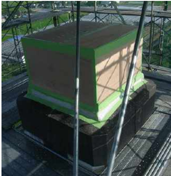
図 4.7.34 煙突開口部養生例
