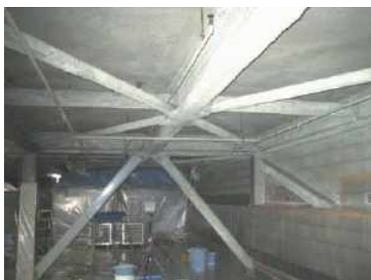
図 4.7.5 同上施工区画の内部側
