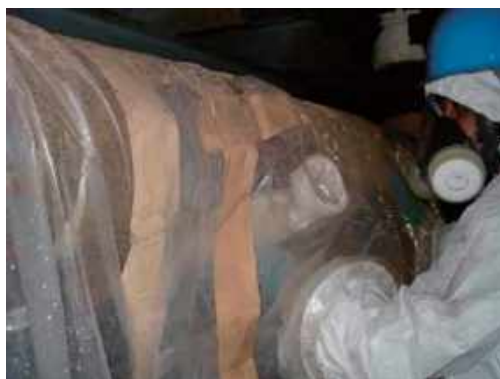
図 4.10.10 石綿除去作業中 2
