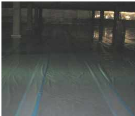
図 4.7.11 床面の負圧隔離養生例 (2重張り)
