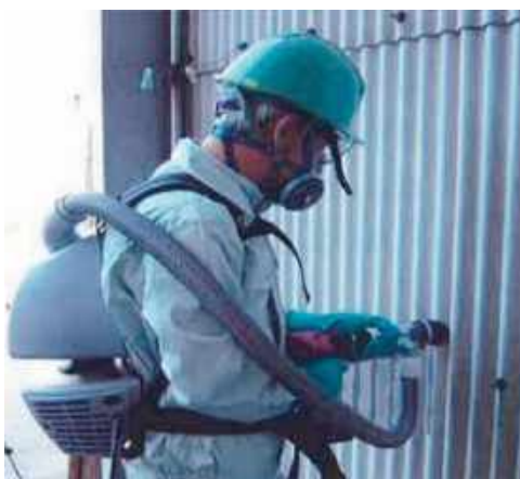
図4.11.7 機械工具による切断例
