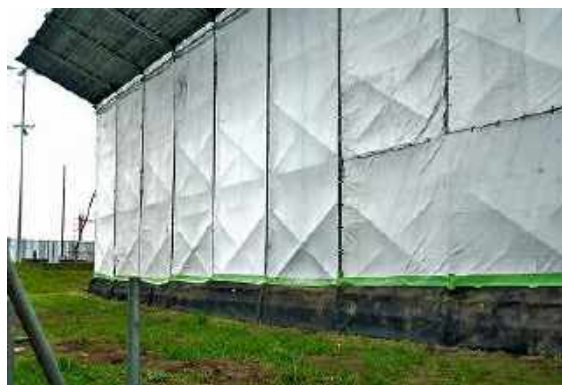
周囲への飛沫飛散防止養生例（外部）
