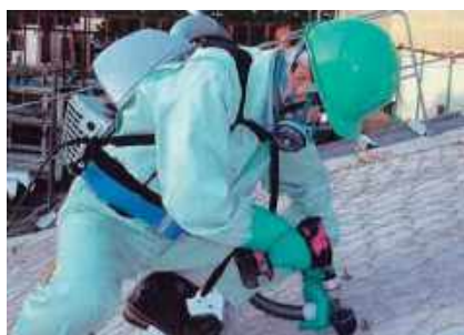
粉じん回収（高性能真空掃除機）
