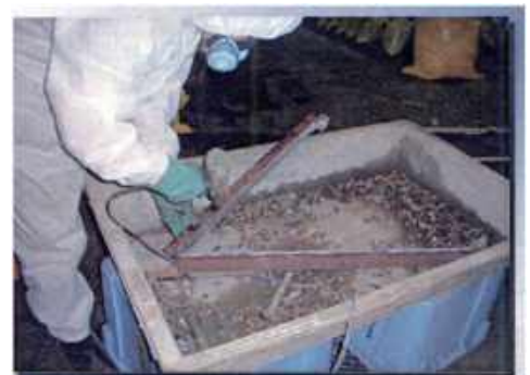
図4.11.17 掻き落とし除去作業の例
